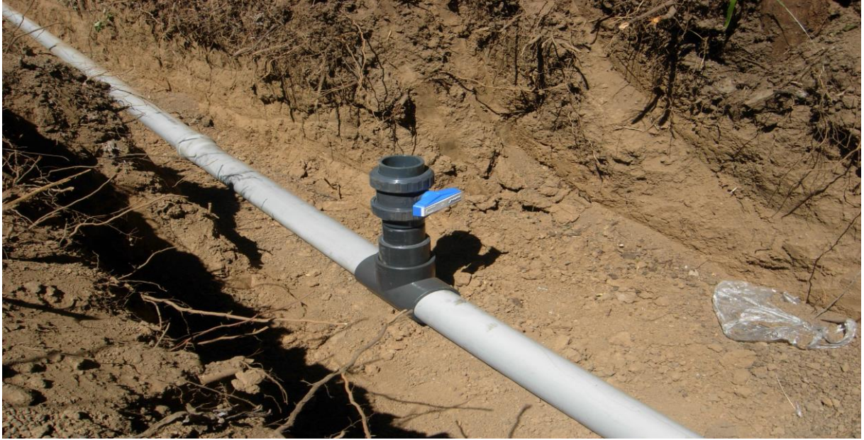
Dereceören Köyü PVC Boru Döşeme
