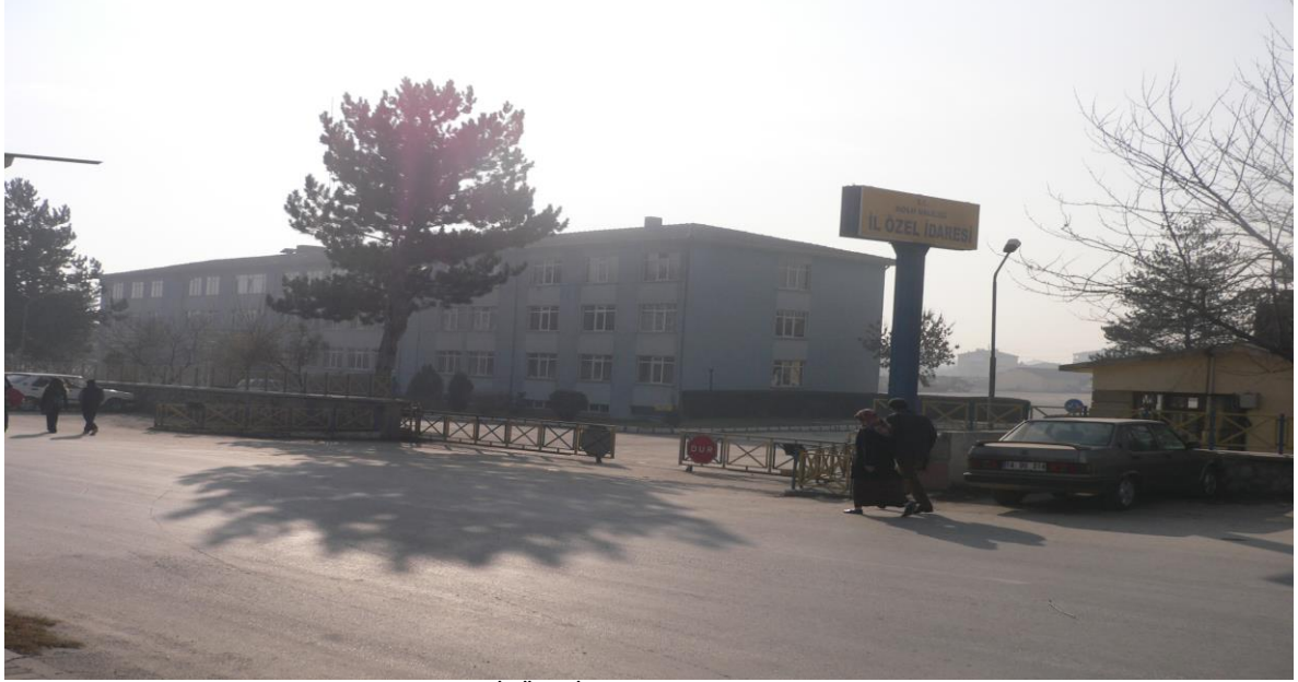
İl Özel İdaresi Hizmet Binası
