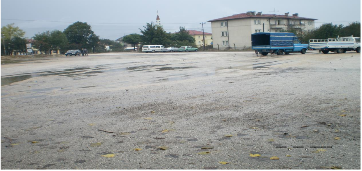
Tepecik mahallesi Vilayetler Hizmet Birliđi Anaokulu (Arsası temin edilerek, arsa hukuki sorunları çözülmüş ve İhalesi gerçekleşmiştir. İhale kara aşamasındadır.)
