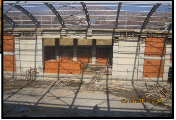
Seben Yibo Çok Amaşlı Salon inşaatı halen devam etmekte olup fiziki ve nakdi gerçekleşmesi %60 seviyesindedir.
