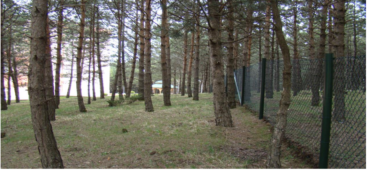
Gerede Huzurevi çevresine tel örgü yapım işi
