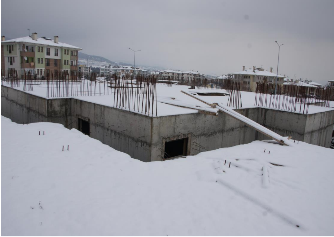
Kalıcı Konutlar Polis Merkezi Amirliği Hizmet Binası İnşaatı
