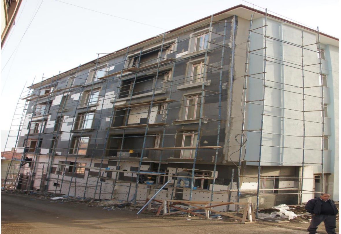
İzzet Baysal Polis Merkez Amirliği Hizmet Binası Güçlendirmesi
