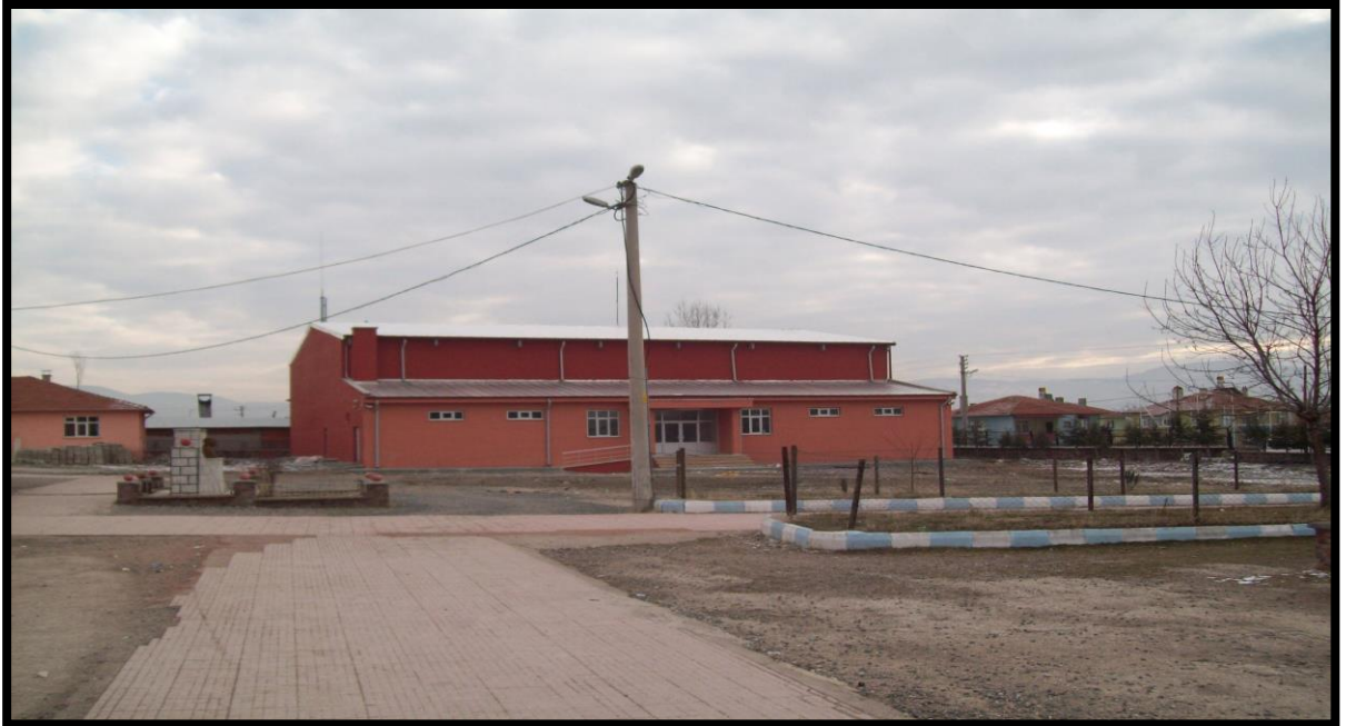
Kıbrısık Yibo Çok Amaçlı Salon İnşaatı tamamlanmıştır.
