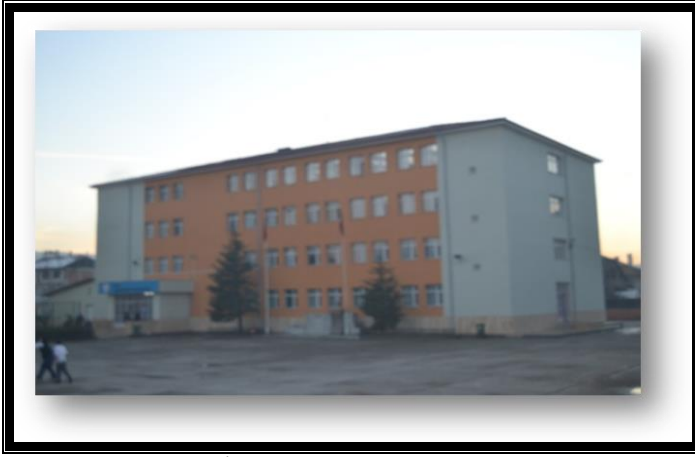
Merkez Cumhuriyet İlkokul ve Ortaokulu Güçlendirilmesi
