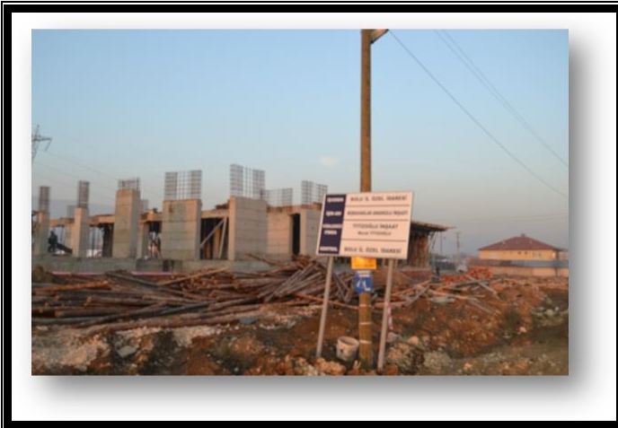
Merkez Beşkavaklar Anaokulu Proje İhale Bedeli 900.000 TL Harcaması 268.800 TL Fiziki Durumu % 30 İl Özel İdaresi Yapımı
