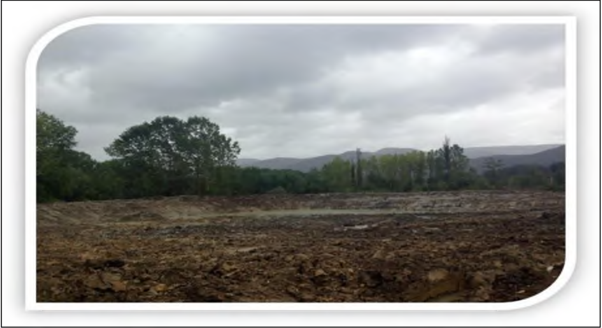
Göynük Arıkçayırı Köyü HİS+KÖS Göleti
