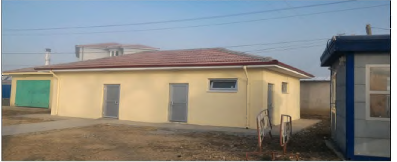
Karaçayır WC Yapım İşi
