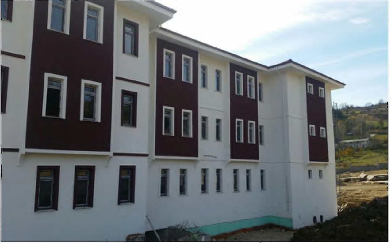
Taşkesti 12 Derslikli Ortaokul Binası Yapım İşi
