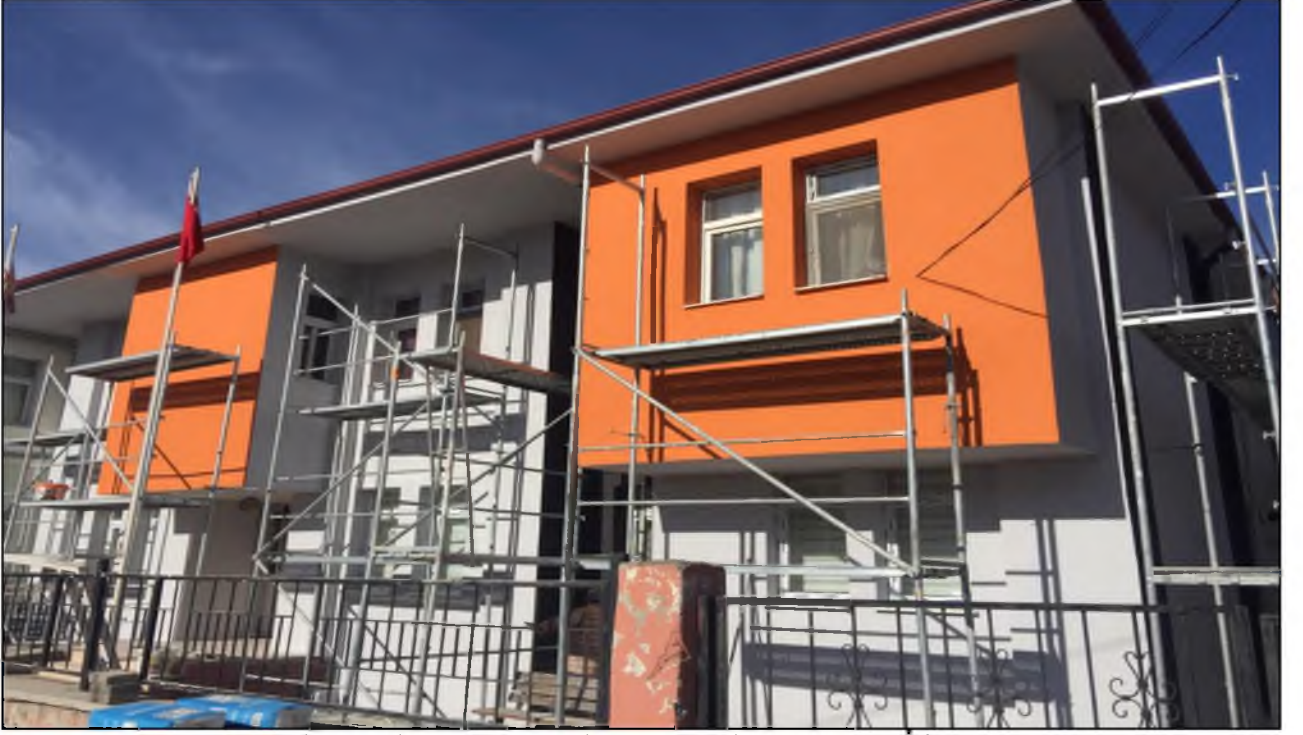
Bolu Semerkant ASM Montalama ve Doğalgaza Dönüşüm İşi
