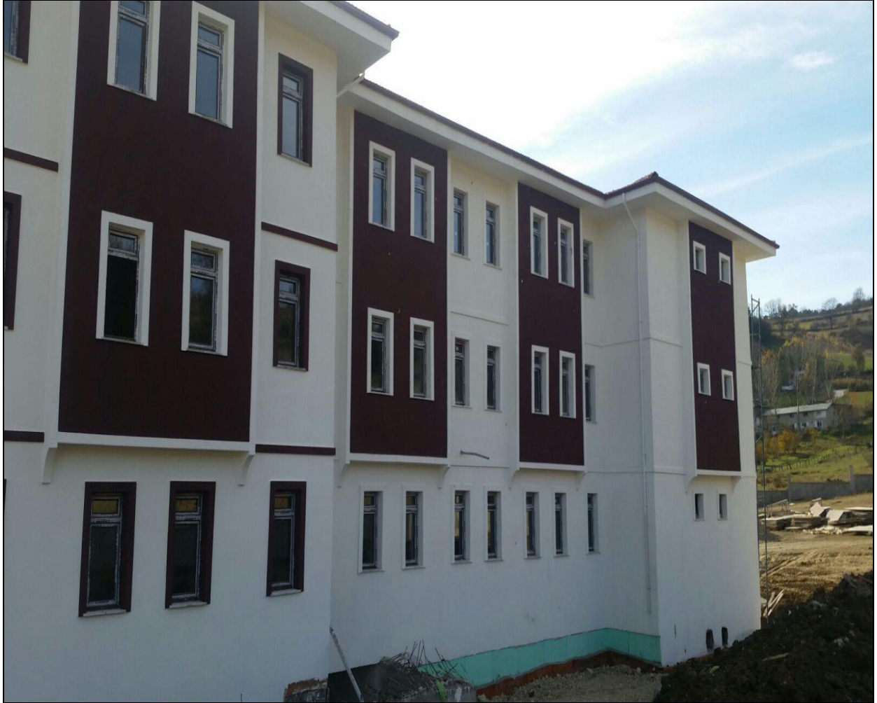
Taşkesti 12 Derslikli Ortaokul Binası Yapım İşi
