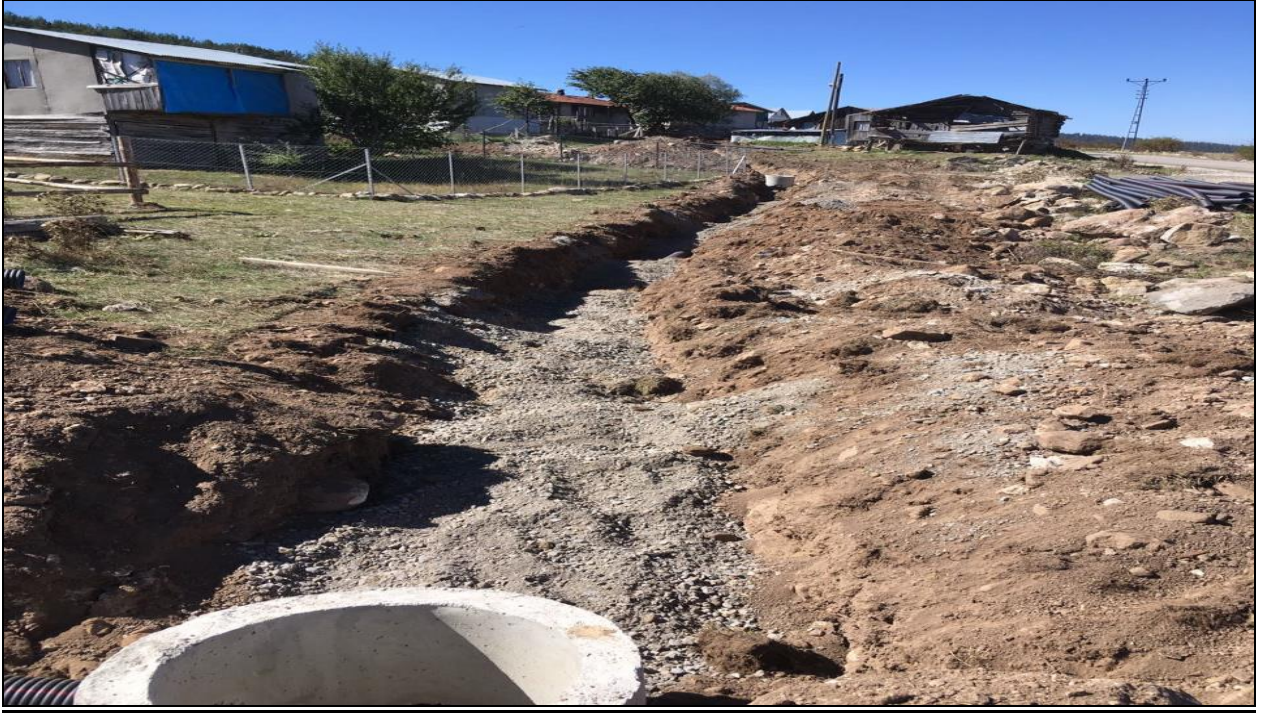
Seben Göleti Adro-Park 5340 m.kazı malzemesinden makine ile hendek ve temel dolgu yapımı görünümü (içmesuyu)
