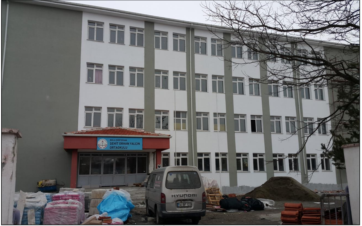
Dörtdivan Şehit Orhan Yalçın İlkokulu Güçlendirme ve Onarım İşi
