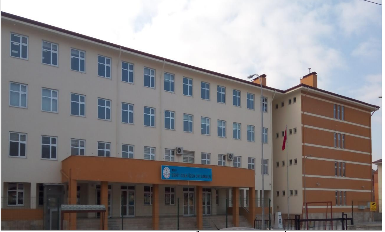
Bolu Merkez Kültür (Şehit Ozan Özen) Ortaokulu Yapım İşi
