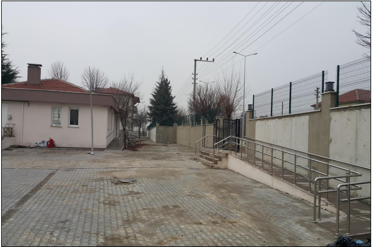
TOBB Kız Meslek Lisesi Atölye Binası Onarımı ve Çevre Düzenleme İşi
