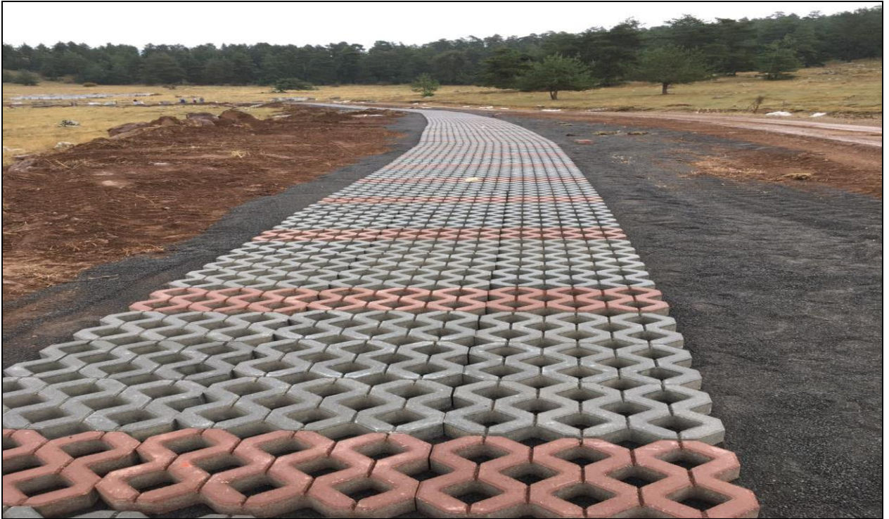
Seben Adro-Park 8 cm. yüksekliğinde normal çimentolu buhar kürlü beton çim taşı ile döşeme kaplama işi yapımından görünüm
