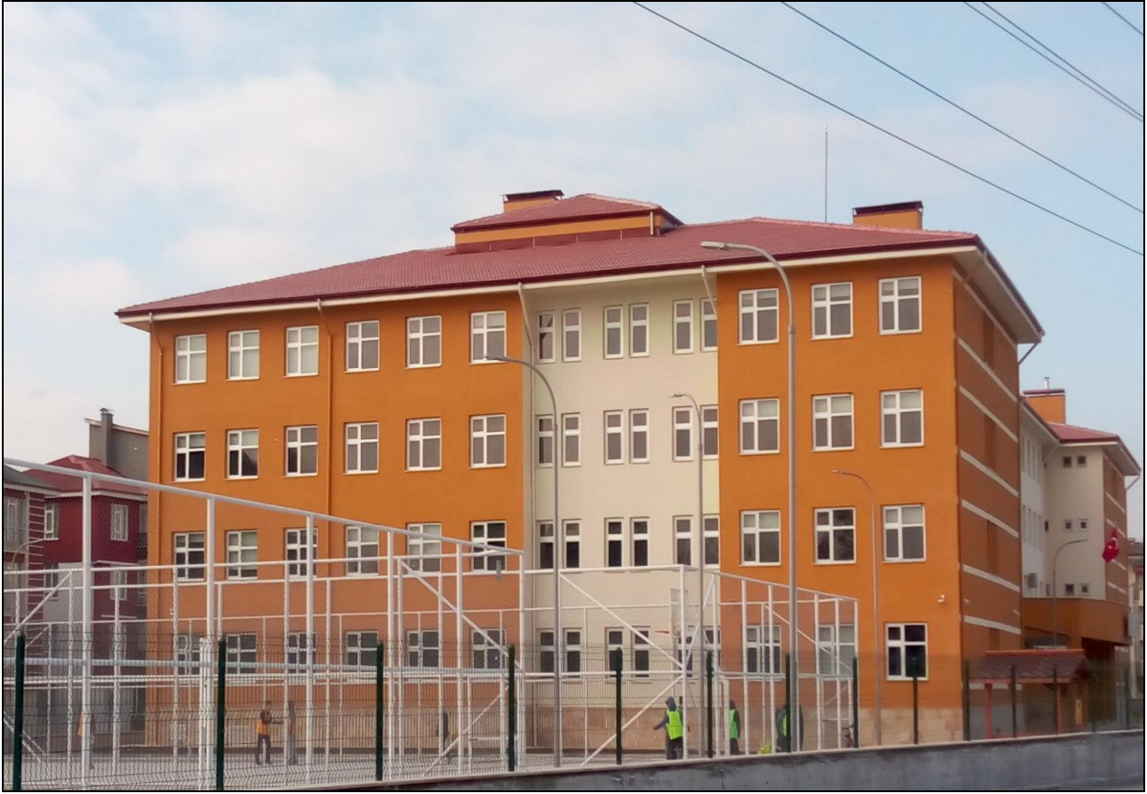
Bolu Merkez Kültür (Şehit Ozan Özen) Ortaokulu Yapım İşi
