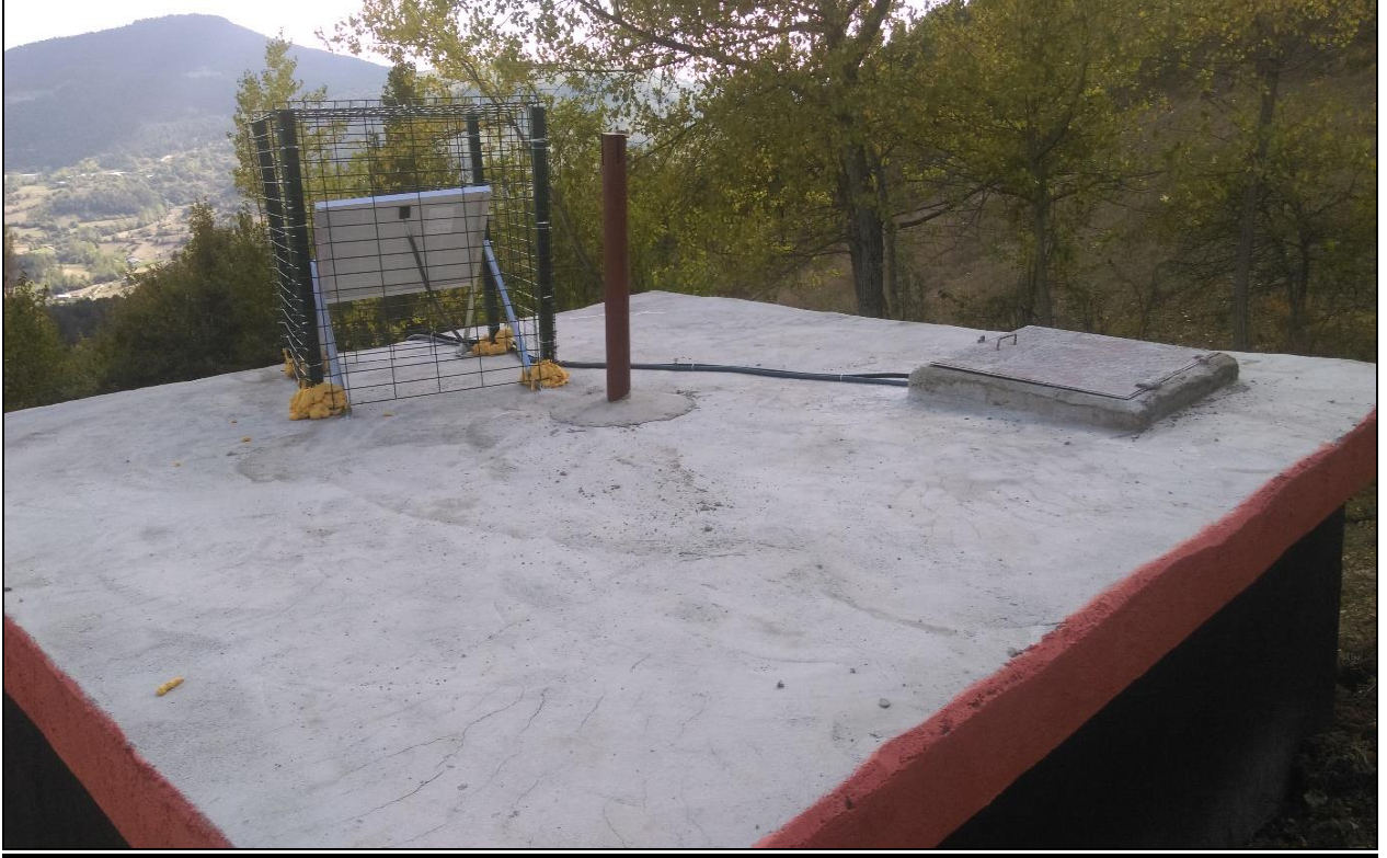
Güneş Enerjili Klorlama Cihazlı Depo
