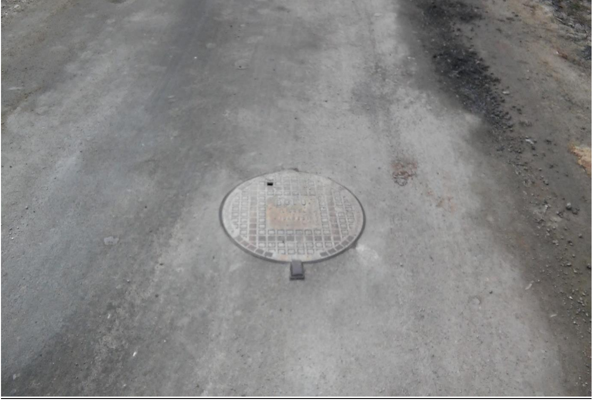
Döküm Kanalizasyon Baca kapağının yapılmış görünümü
