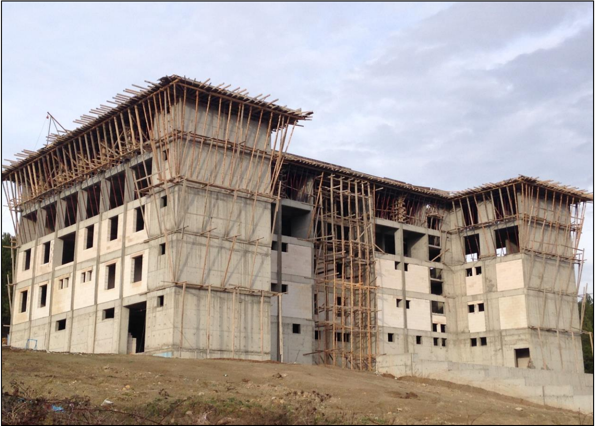
Mengen 200 Kiřilik Yurt Binası Yapımı İři
