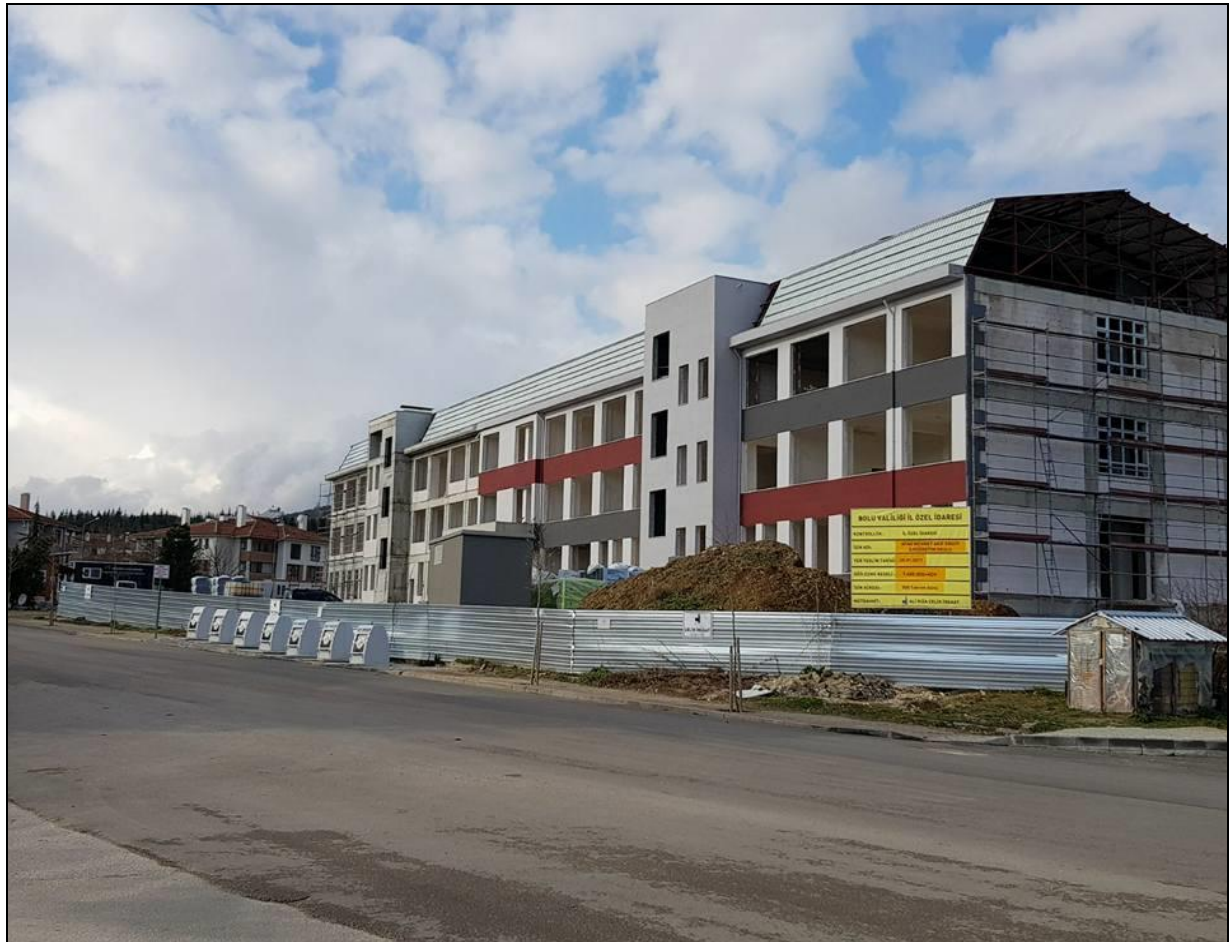
Bolu AFAD Mehmet Akif Ersoy İlkokulu Yapımı İşi
