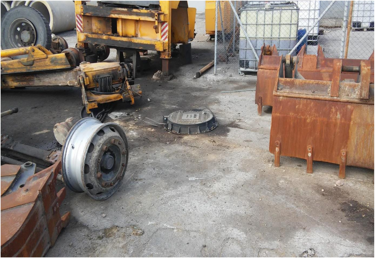
Döküm Kanalizasyon Baca kapağının yapılmamış görünümü
