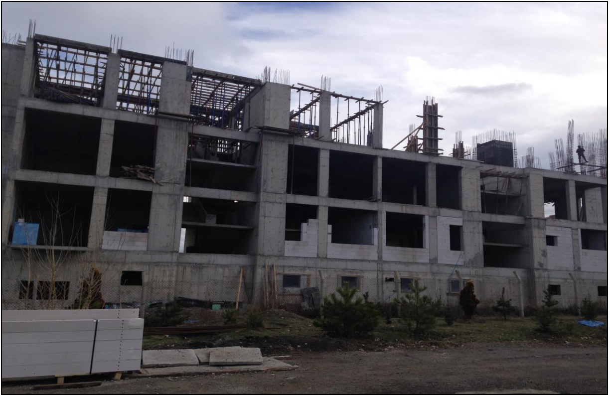
Yeniçağa 16 Derslikli İmam Hatip Lisesi Yapımı İşi
