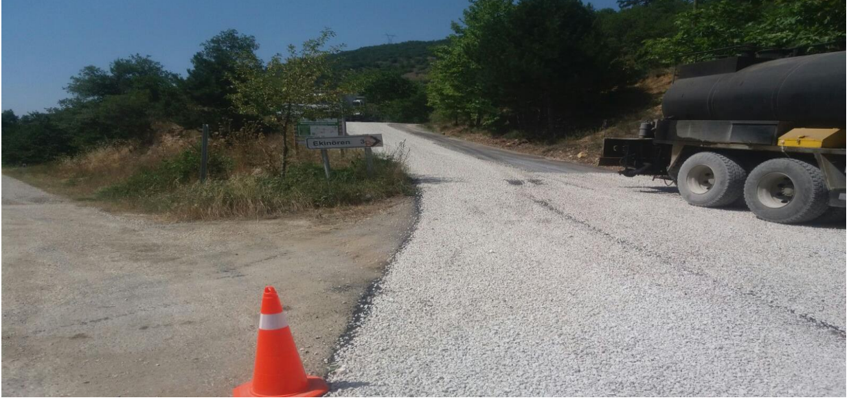
Asfalt Çalışmalarından Görünüm
