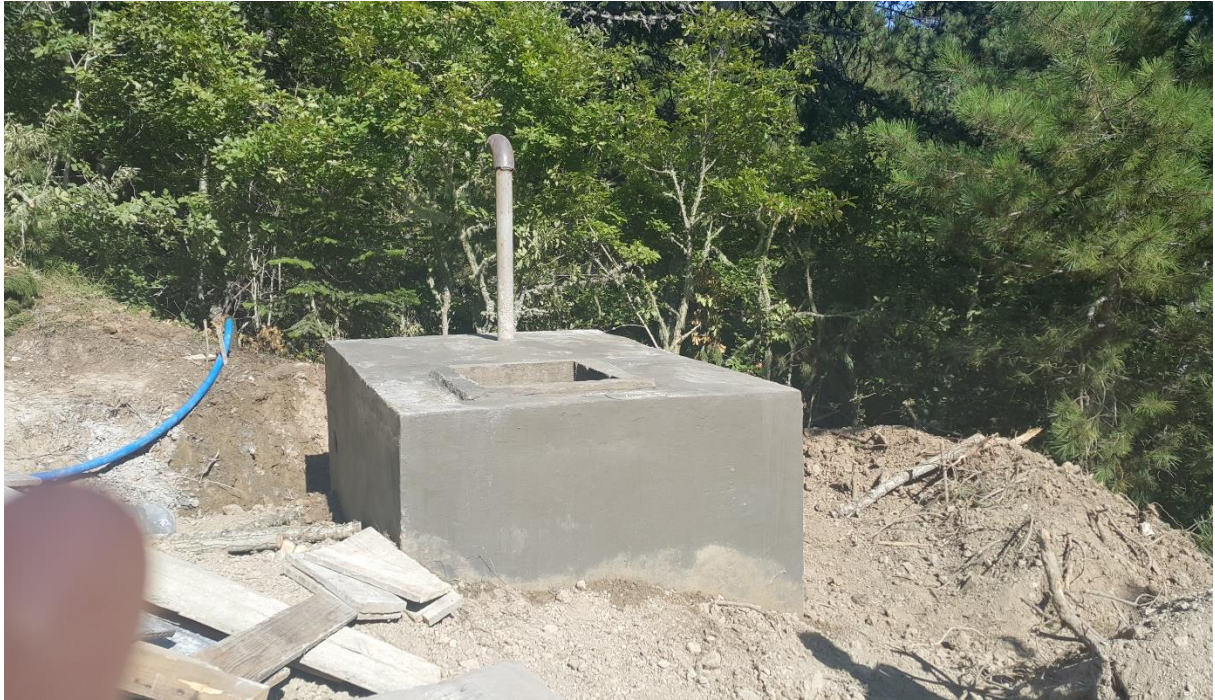
Beton Kaptaj Görünümü
