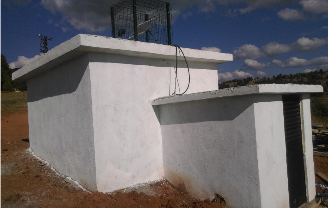
30 Tonluk İçmesuyu Depo Görünümü
