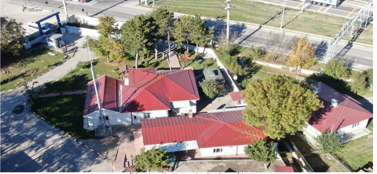
İl Jandarma Alay Komutanlığı Çatı Onarım İşİ
