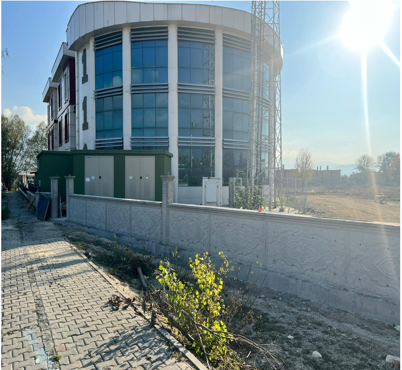
112 Acil Çağrı Merkezi Çevre Duvarı
