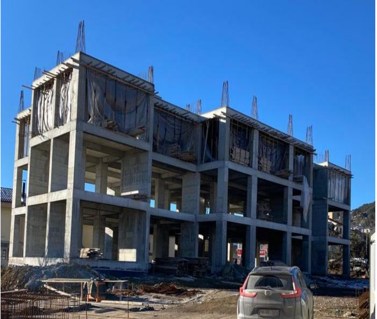
Gerde Hükümet Konağı İnşaatı
