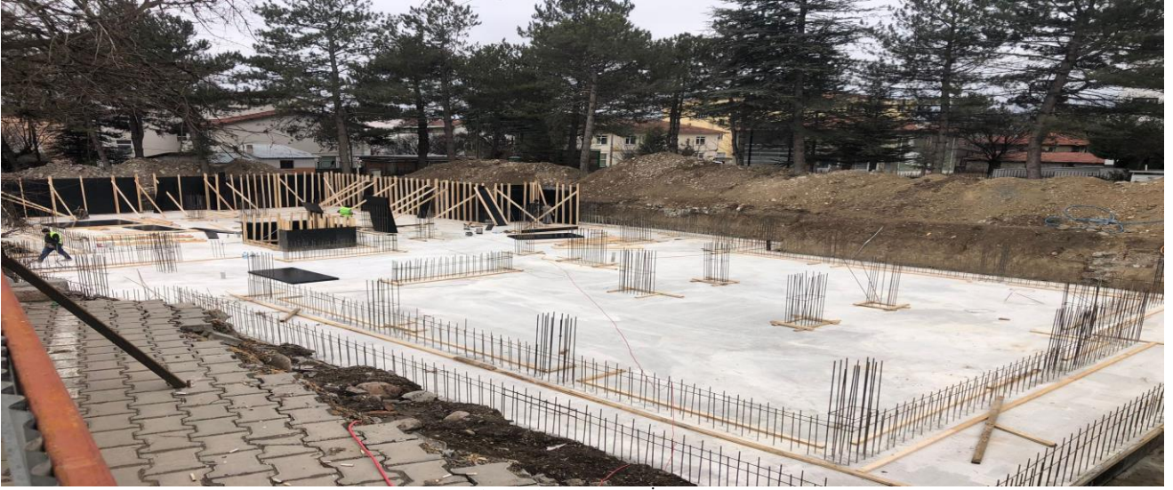
Seben Hükümet Konağı İnşaatı
