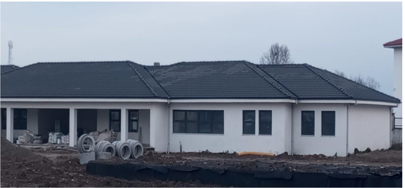
Bolu Engelsiz Yaşam Bakım ve Rehabilitasyon Merkezi Yapım İşi
