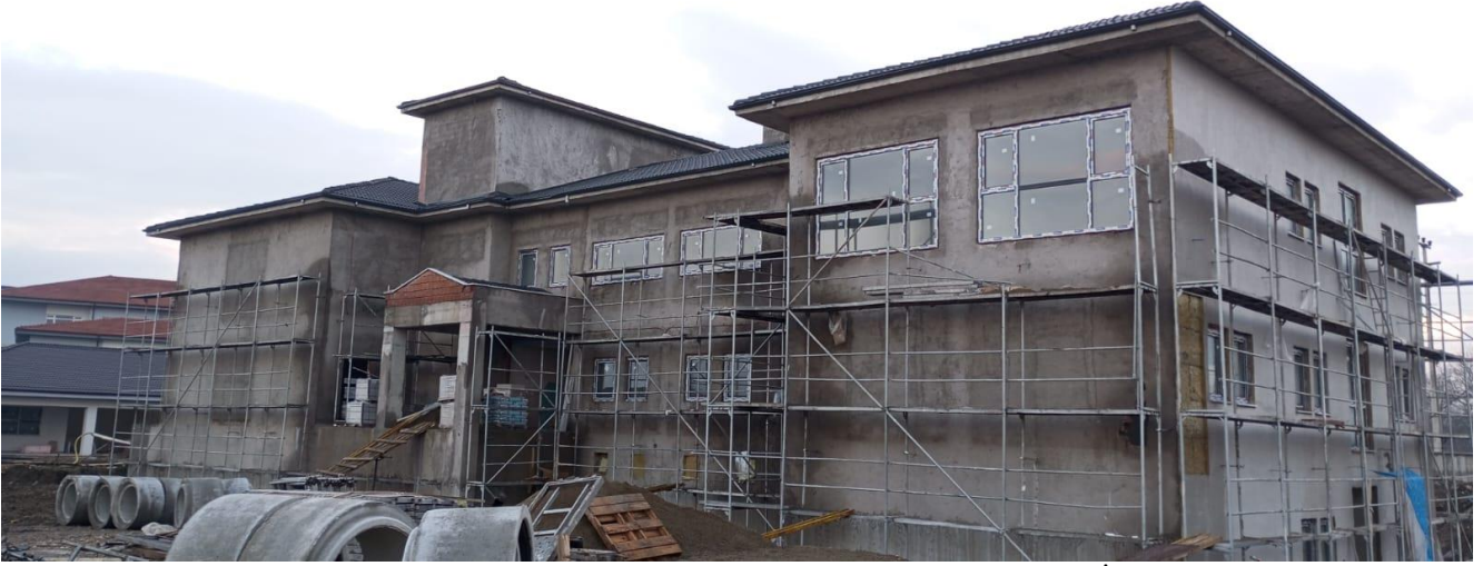
Bolu Engelsiz Yaşam Bakım ve Rehabilitasyon Merkezi Yapım İşi
