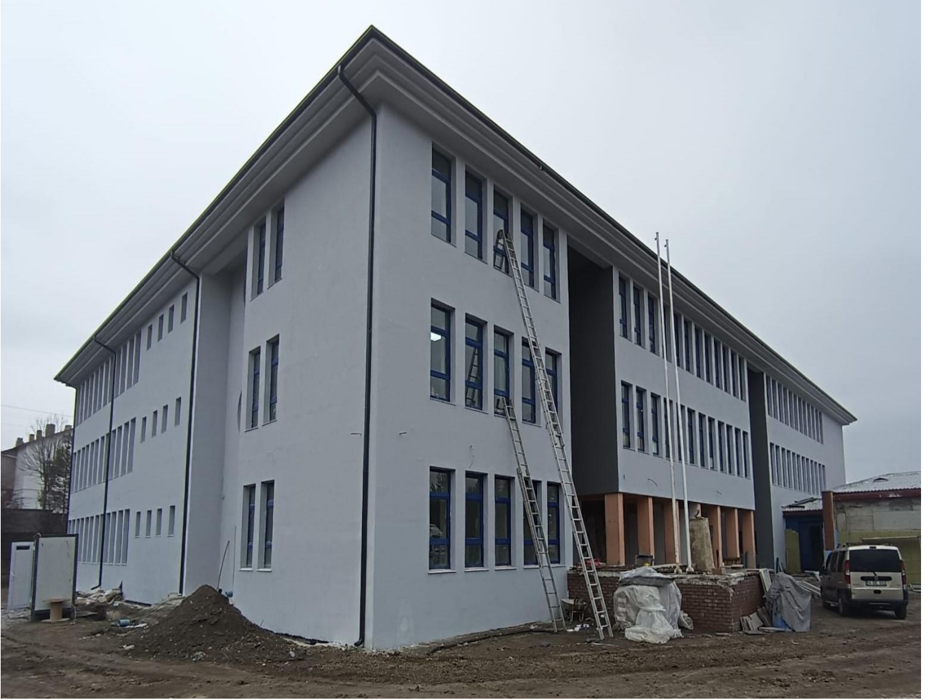
Bolu Gerede Yenimahalle İlk ve Ortaokulu Güçlendirme ve Onarım İşi
