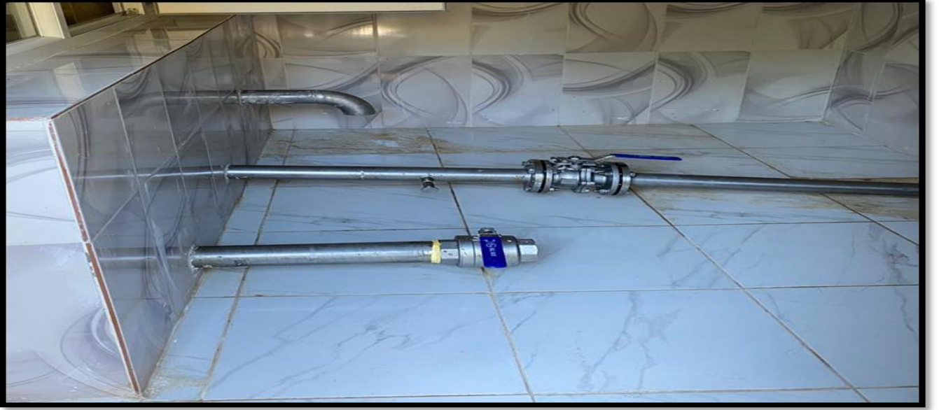
Taşkesti Su Fabrikası ve Kaynağı
