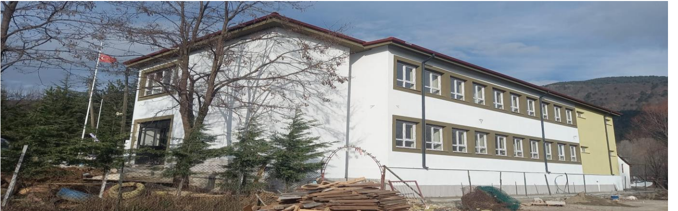
Bolu Merkez Çobankaya Şehit Murat Paçal İlkokul Binası
