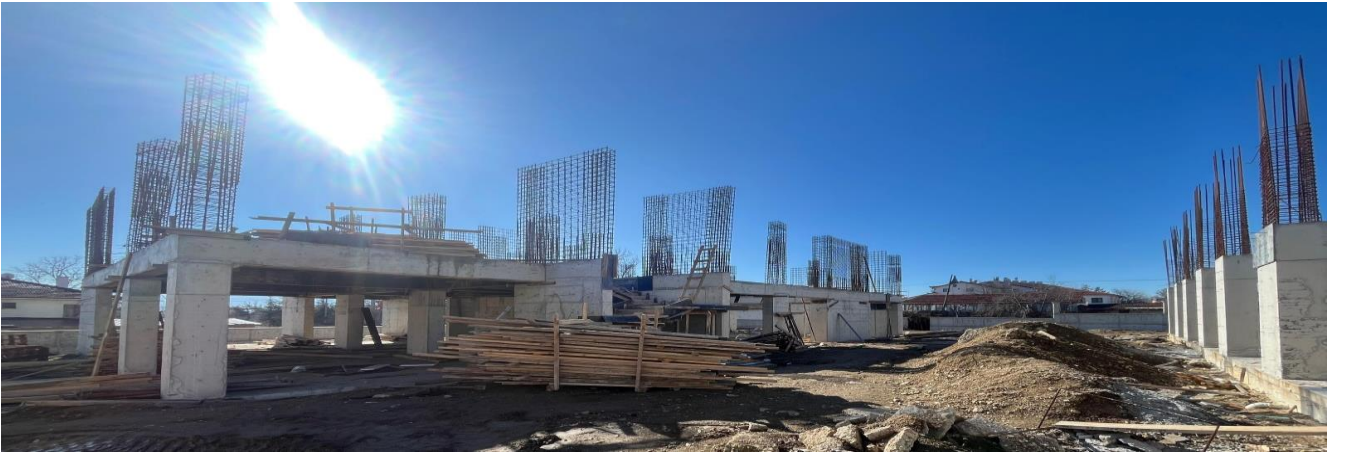
AFAD İl Hizmet Binaları ve Yönetim Merkezi Binaları Yapım İşi
