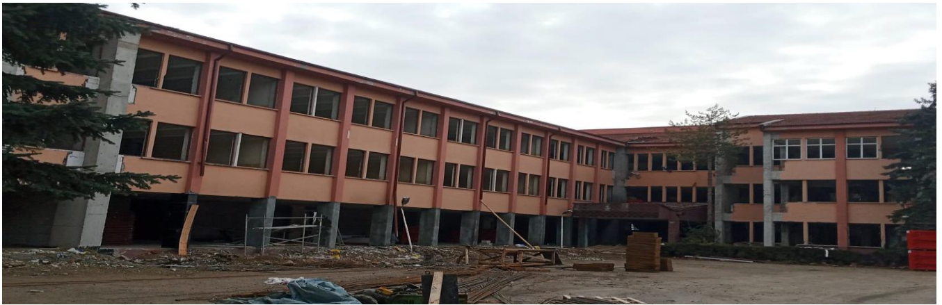
Bolu İzzet Baysal Anadolu Lisesi Okul Binası Güçlendirme ve Bakım Onarım İnşaatı
