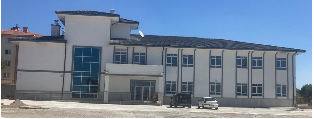
Bolu İli Gerede İlçesi Demirciler Mah. Anaokulu Binası Yapım İşİ
