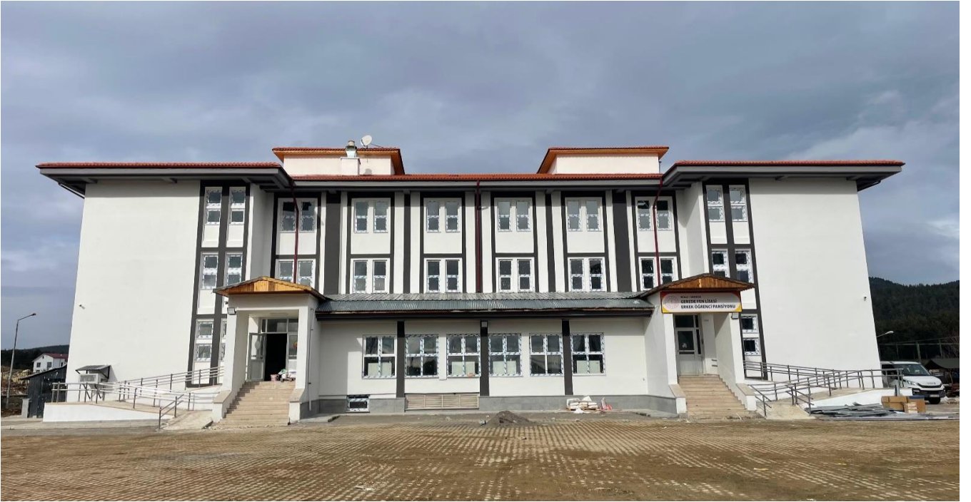
Bolu İli Gerede İlçesi ve Pansiyonu Güçlendirme ve Onarım İşİ
