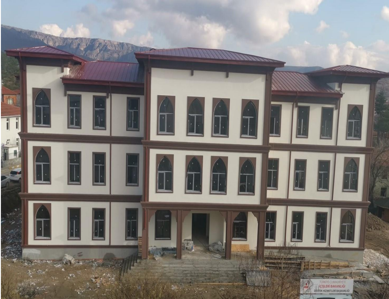
Seben Hükümet Konağı
