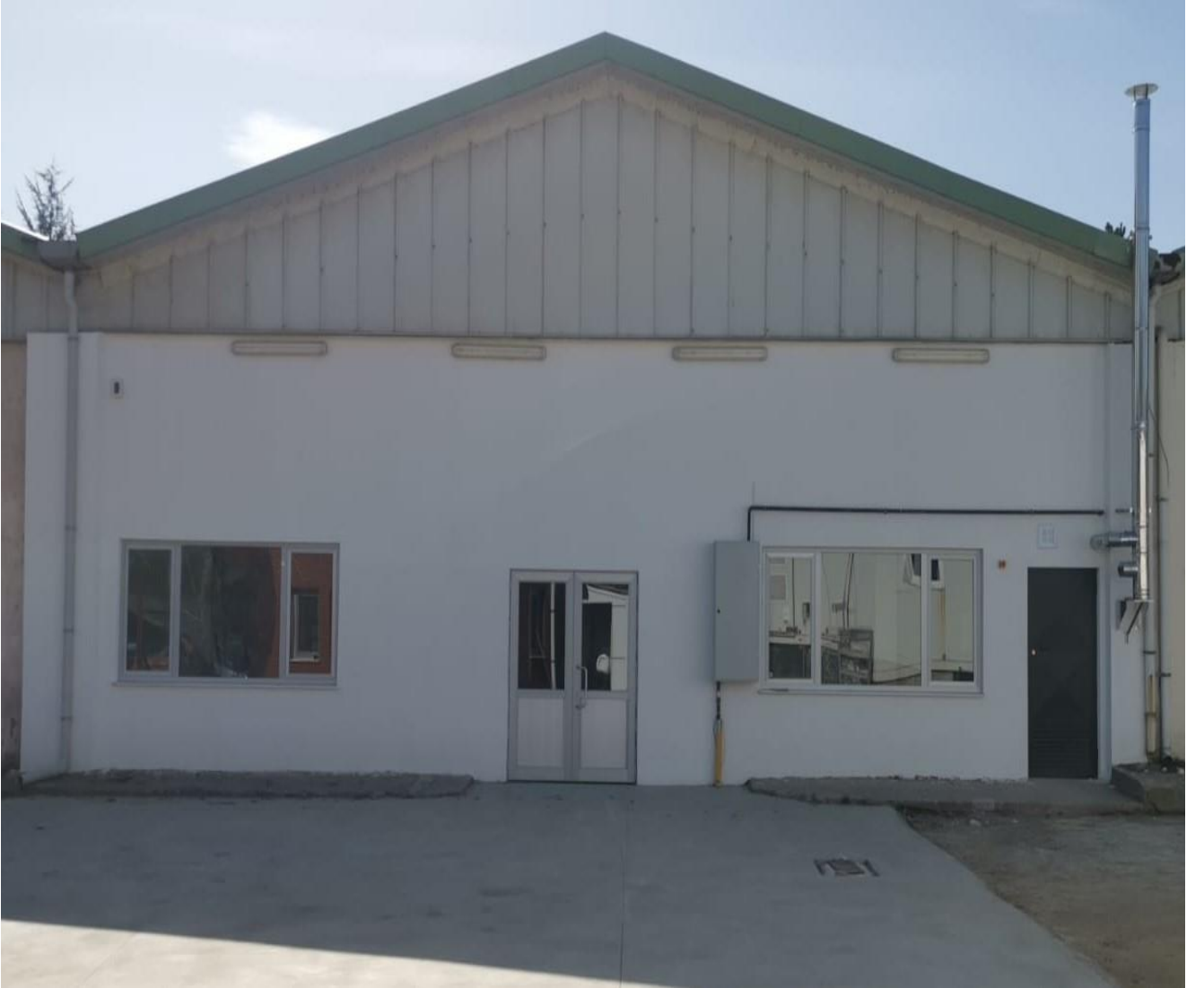
Göç İdaresi Müdürlüğü Geri Gönderme Merkezi Binası
