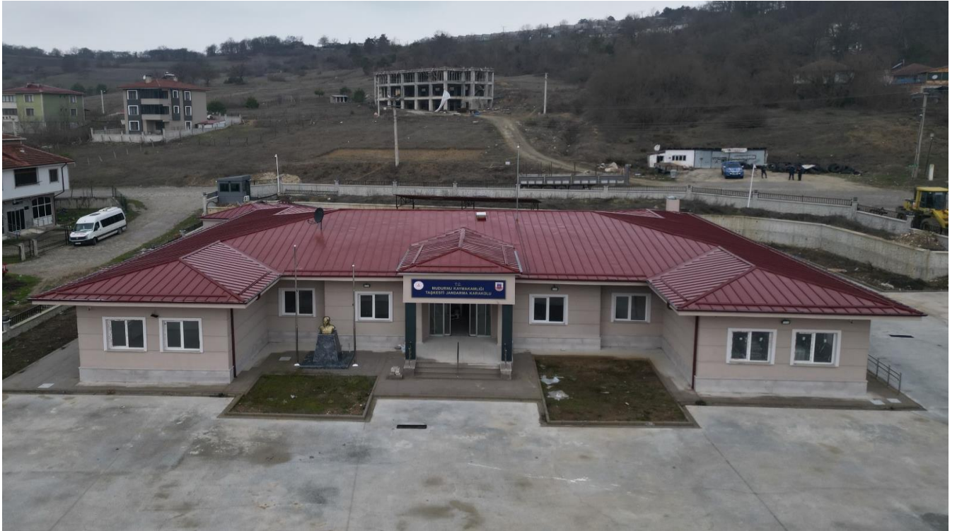
Mudurnu- Taşkesti Beldesi Jandarma Komutanlığı Yeni Hizmet Binası
