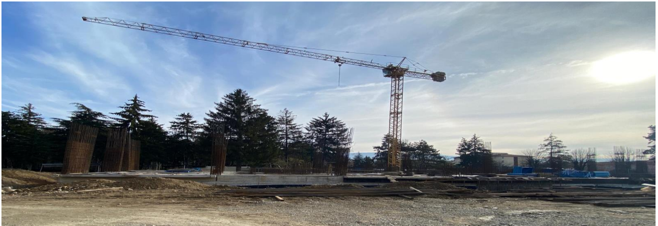
Bolu Merkez 100 Yataklı Uygulama Oteli Binasi İnşaatı Yapım İşİ
