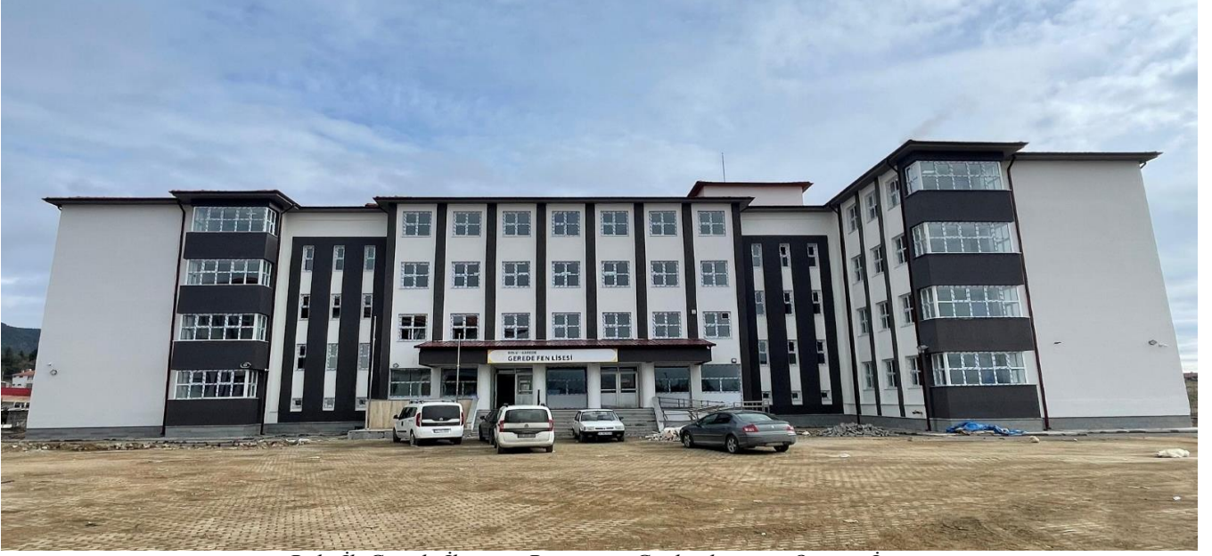
Bolu İli Gerede İlçesi ve Pansiyonu Güçlendirme ve Onarım İşİ
