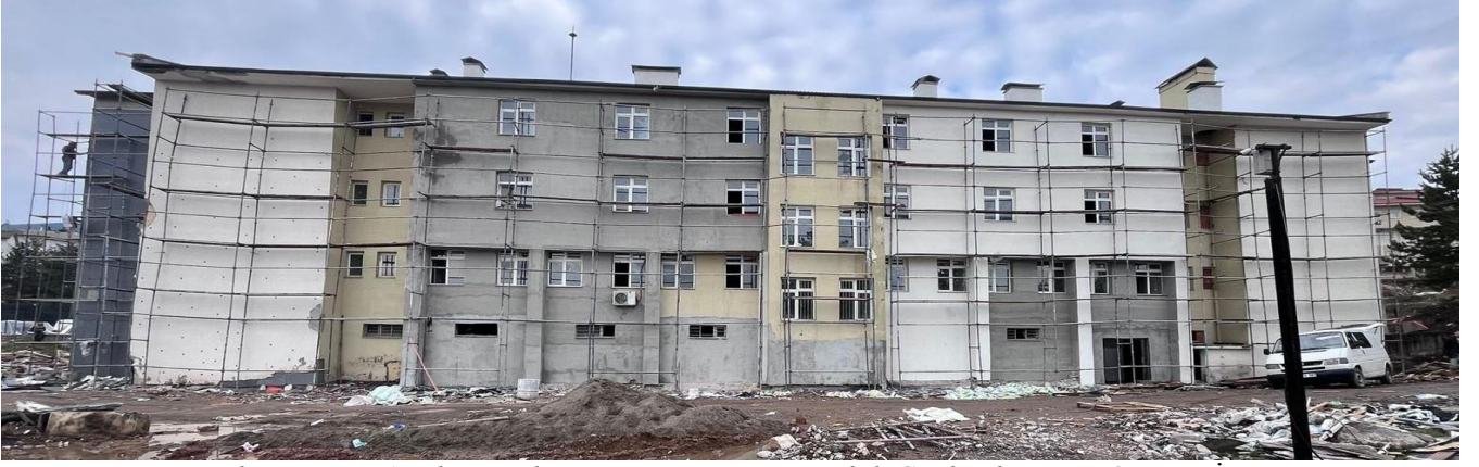
Bolu Mengen Aşçılar Mtal Pansiyon Binası ve B Blok Güçlendirme ve Onarım İşi
