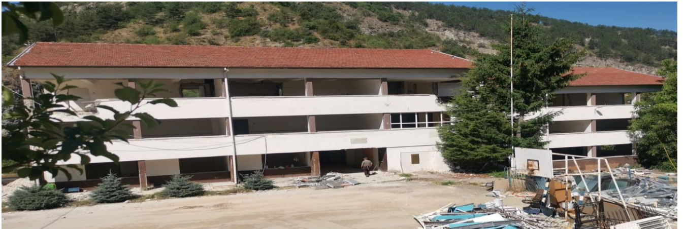
Bolu Mudurnu Ortaokulu Binası Güçlendirme ve Onarım İnşaatı İşİ
