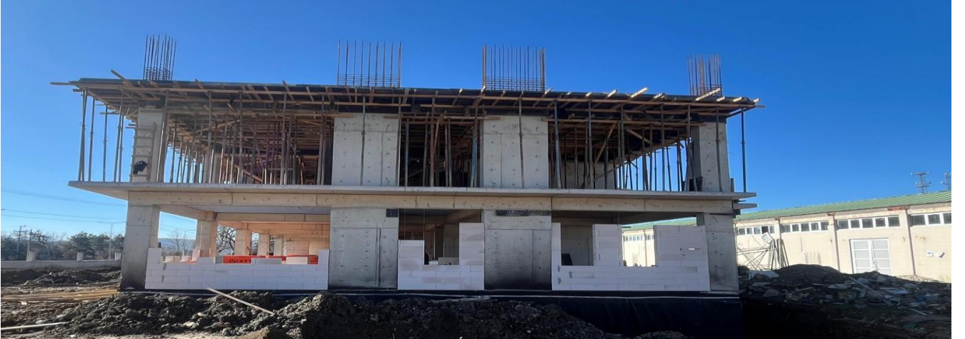
AFAD İl Hizmet Binaları ve Yönetim Merkezi Binaları Yapım İşi
