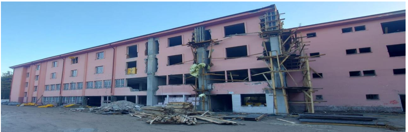
Bolu İzzet Baysal Anadolu Lisesi Pansiyon Binası ve Eski Kazan Dairesi Binası Güçlendirme ve Bakım İşİ
