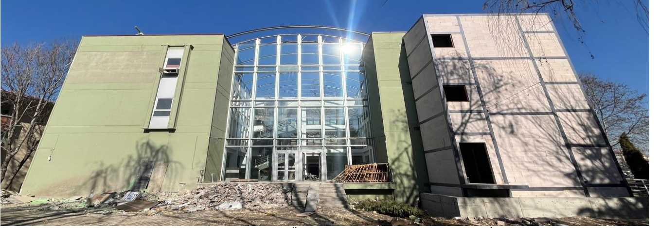
Bolu Solmaz Ahmet Baysal Öğretmenevi Güçlendirme ve Onarım İşİ
