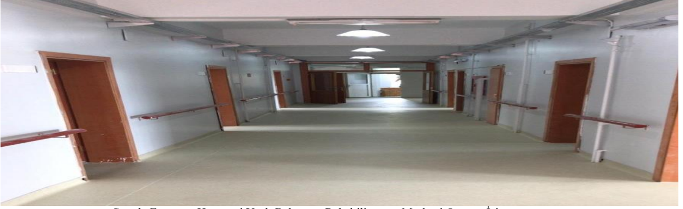
Gerede Esentepe Huzurevi Yaşlı Bakım ve Rehabilitasyon Merkezi Onarım İşi
