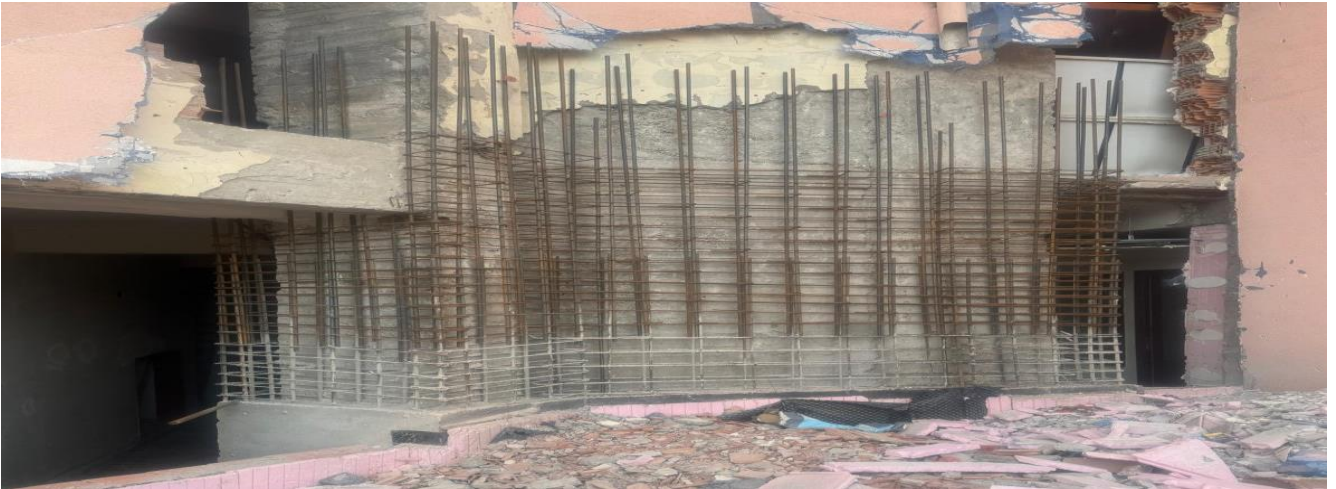
Kültür ve Turizm Müdürlüğü Binası Güçlendirme ve Onarım İnşaatı
