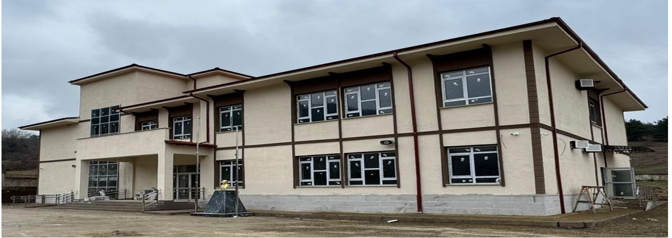
Bolu İli Mudurnu İlçesi Taşkesti Beldesi Anaokulu Binası Yapım İşİ
