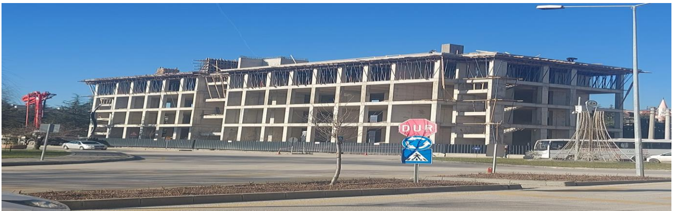
Bolu Merkez Gazipaşa İlkokulu 32 Derslikli Okul Binasi Yapım İş
