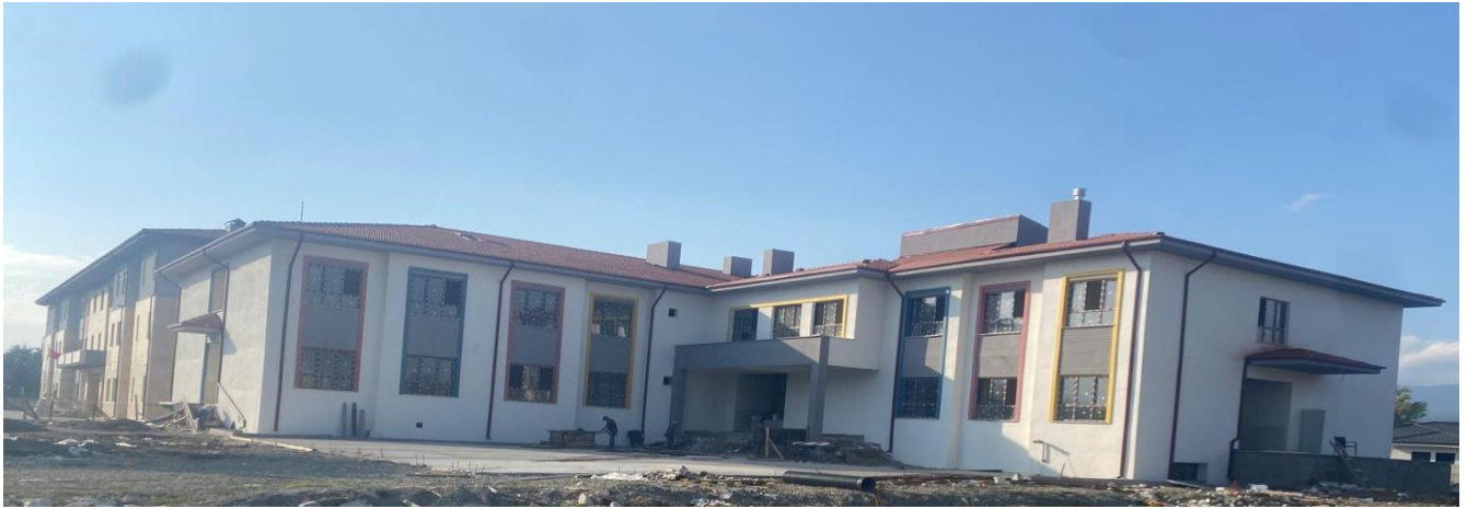
Merkez Özel Eğitim Anaokulu Binası
